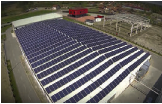
SLIKA 4. Solarna elektrana na krovu fabrike
